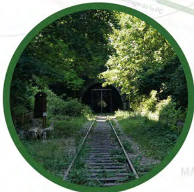
Tronçon à ouvrir
