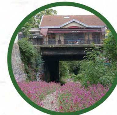
Tronçon à ouvrir
