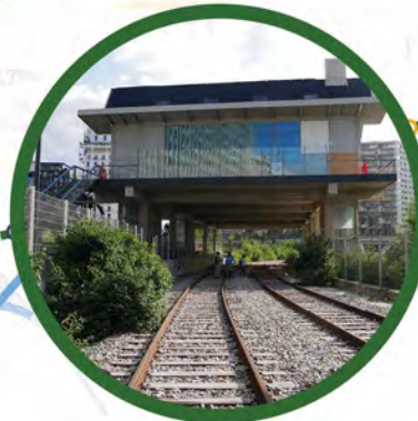
Tronçon à ouvrir
