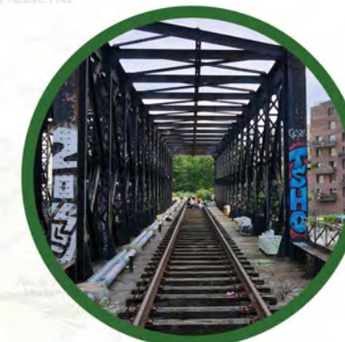
Tronçon à ouvrir
